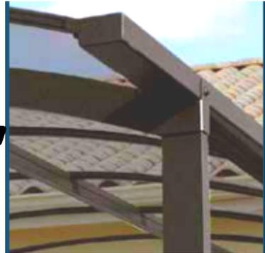
**Les carports se composent d'une structure en aluminium hormis les arceaux de toit. Ce qui nécessite peu d'entretien.**
